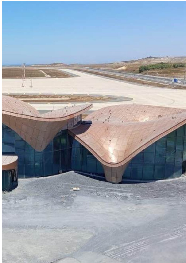
DUVAR KAPLAMA / WALL CLADDING
